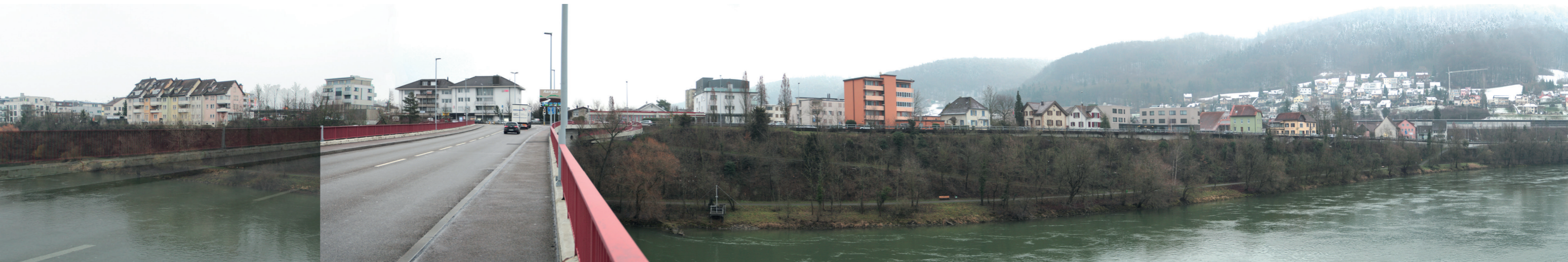
Abbildung 20: Ansicht Schaffhauserstrasse Bestand.
